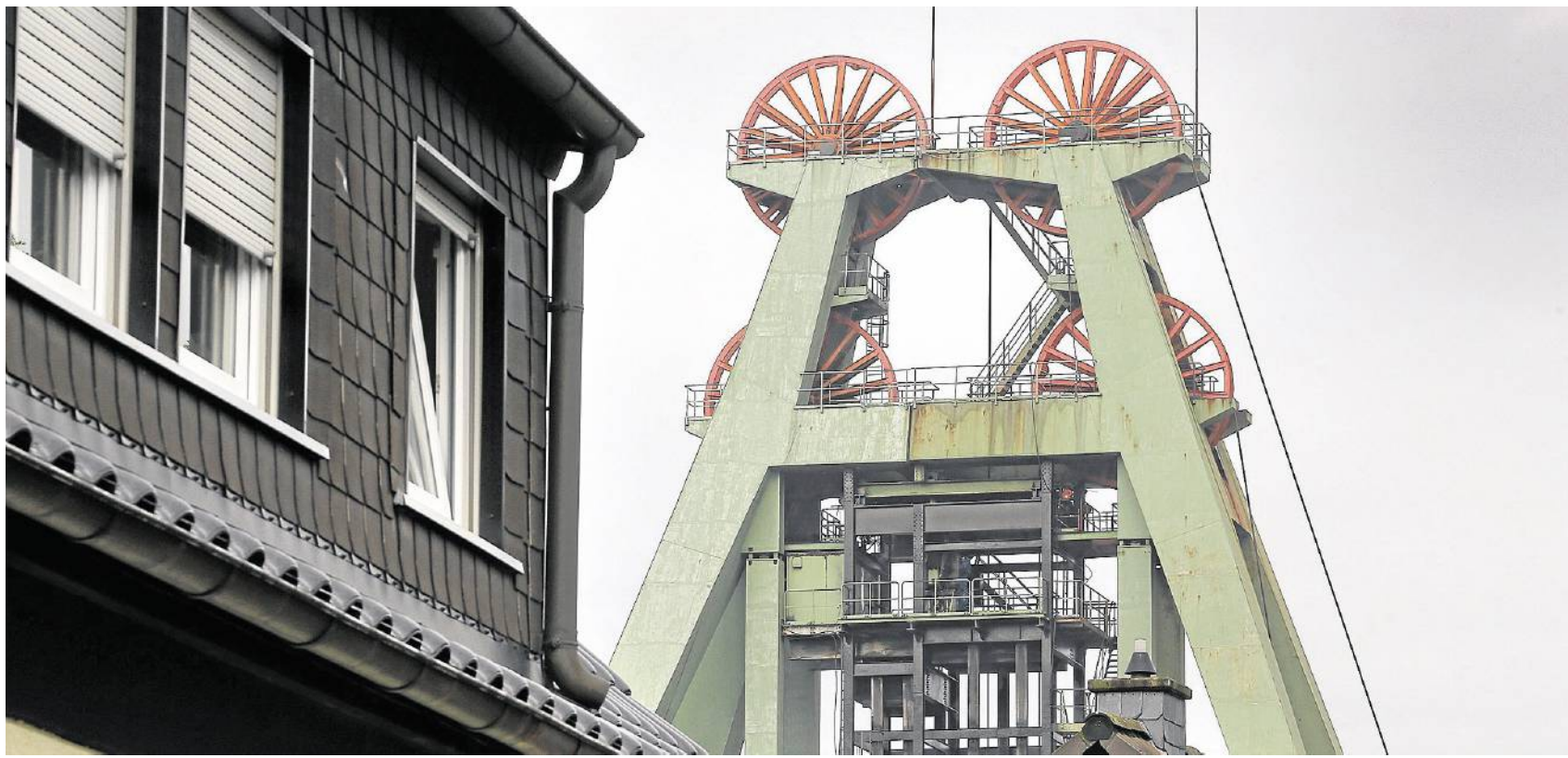
Der Bergbau hat seine Spuren in Bergkamen hinterlassen. Für viele Hauseigentümer geht es jetzt darum rechtzeitig Bergschäden festzustellen und bei der RAG zur Entschädigung anzumelden.
